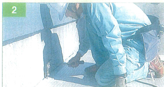
2 FL銅板の取付け
