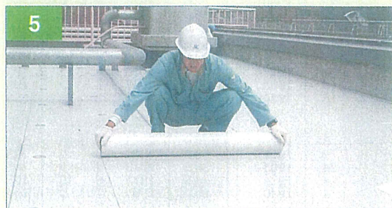
5 リベットルーフの敷設
